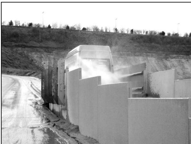
Figure 10 : Installation de lavage de roues de camions
