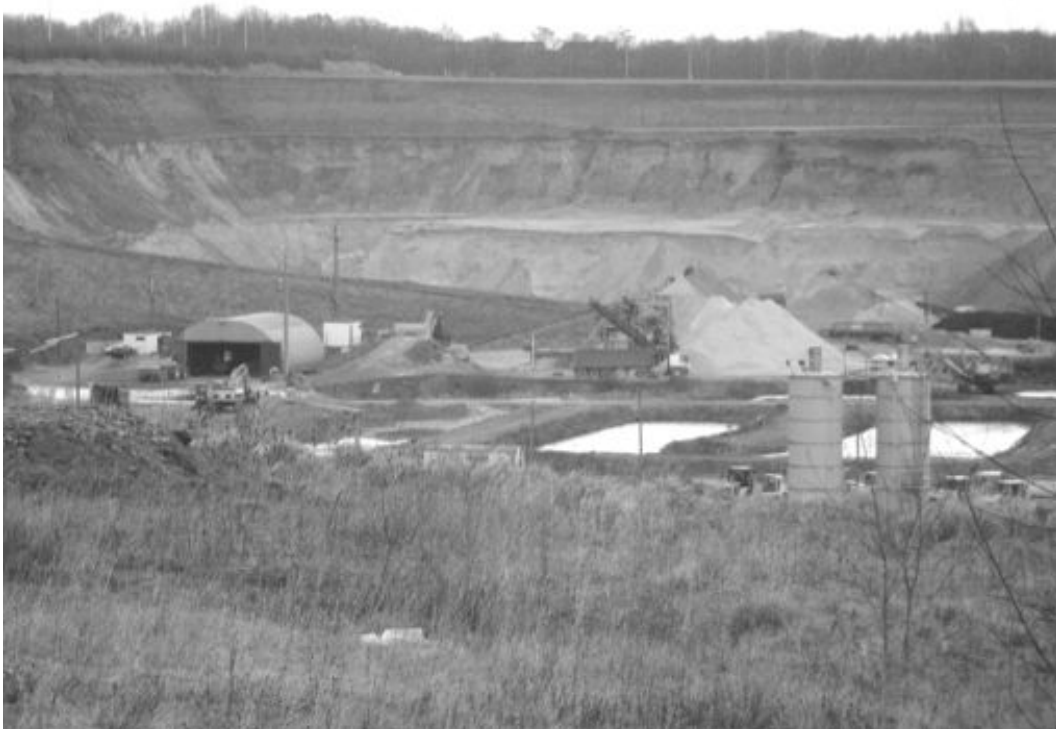
Vue générale de la sablière
