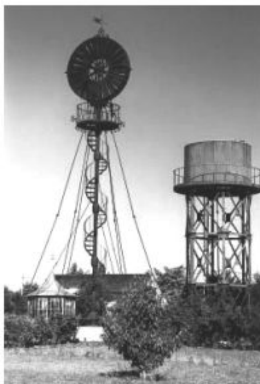
Eolienne multipale 2 et réservoir
